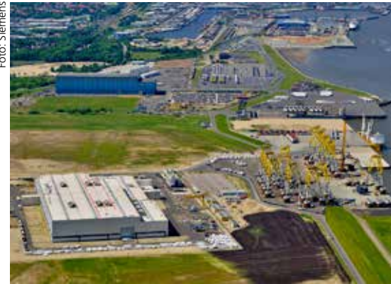
Das neue Werk für Windturbinen in Cuxhaven
