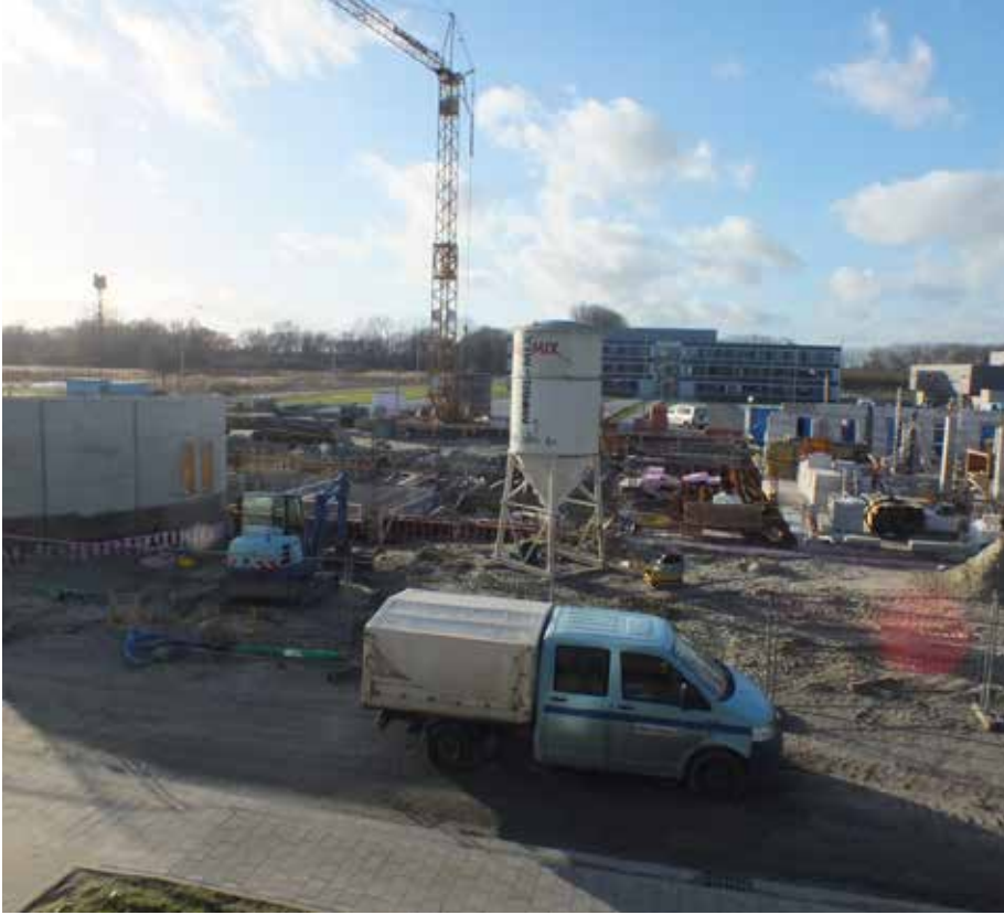
Baustelle der Westerweiterung
